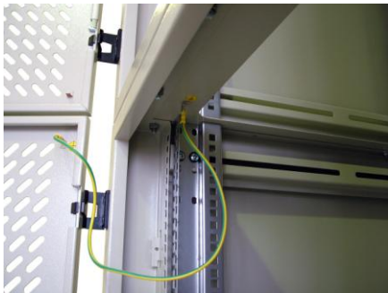
Рисунок 2: Стыковочный узел оборудование стандартов 21" и 19" любой глубины.
